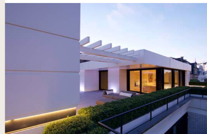
Design: Gerdt Architektur, Hamburg | Fabrication: Kiebitzberg GmbH & Co.KG, Havelberg | Photo credit: ©Klaus Stemmler
