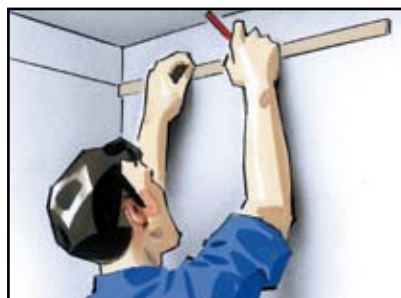
Markera listens placering med ett streck på väggen.
